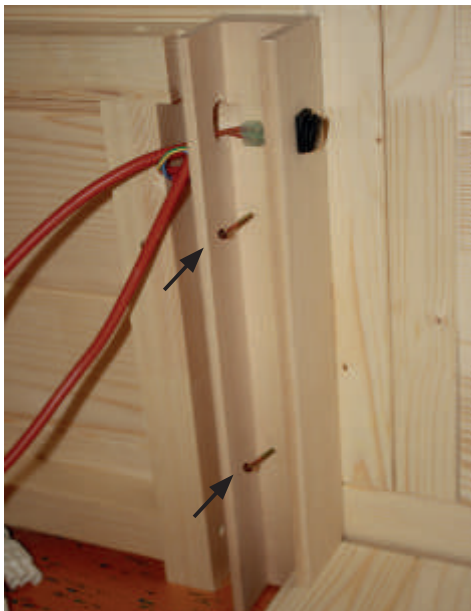
Abb. 33: Montage der U-Leisten für Wärmeplatten
