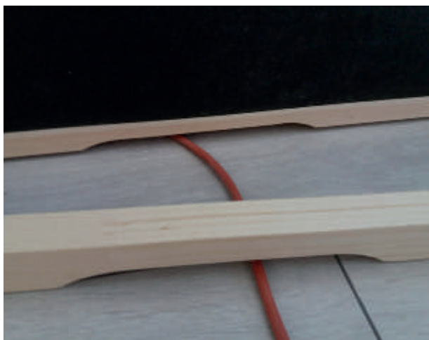
Abb. 35: Einsetzen der Aussteifungsleiste für IR-Wärmeplatten VitaMy
