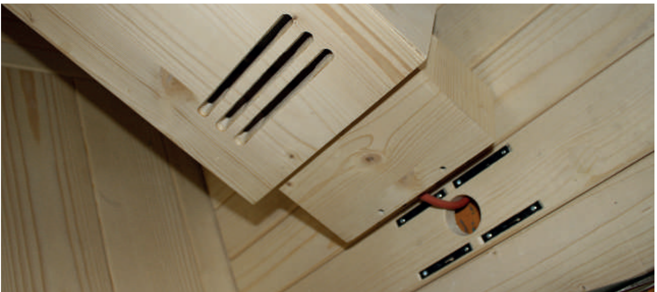
Abb. 29: Frontstrahler fixieren
