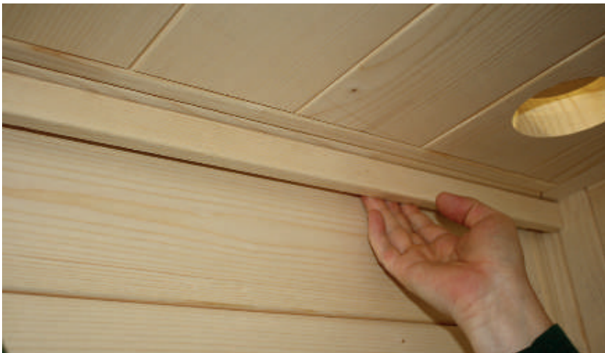
Abb. 38: Einkleben des LED Stripes
