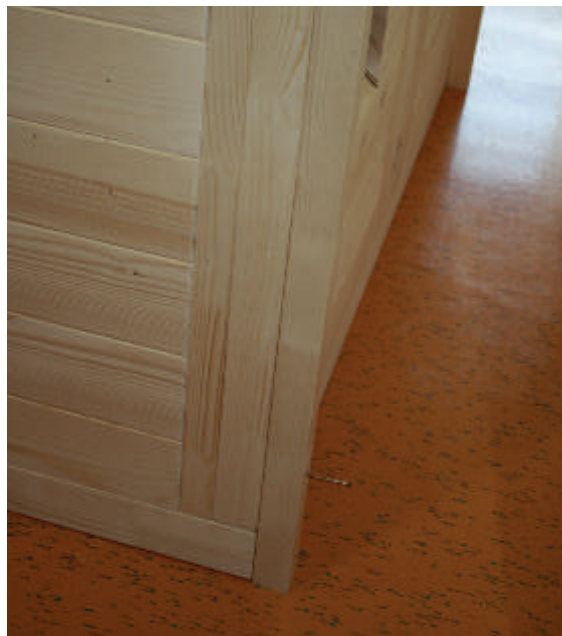
Abb. 52: Montage Abstandleisten Rückwand
