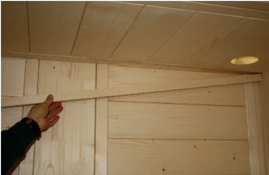
Abb. 37: Montage der LED-Abdeckleiste
