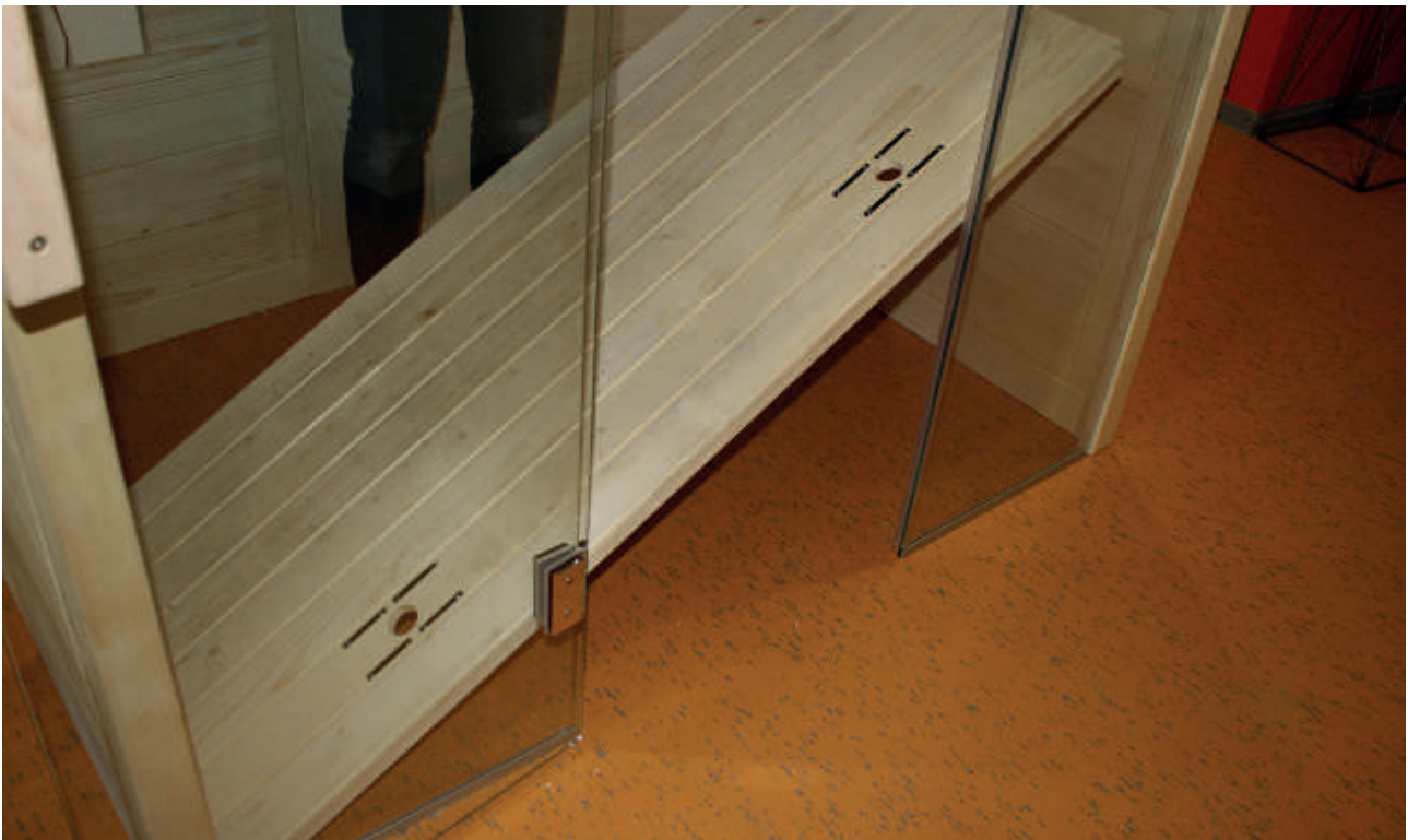
Abb. 28: Kabinenboden einlegen
