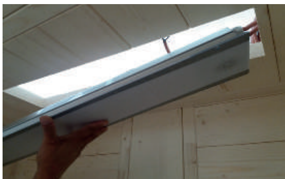
Abb. 50: Montage Farblampe
