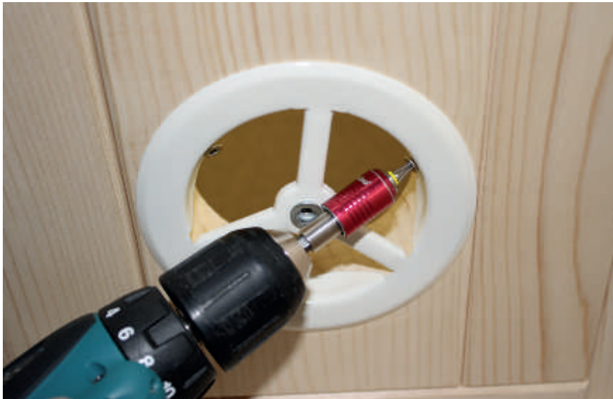
Abb. 36: Montage der Entlüftung
