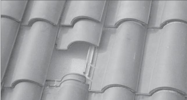
Entfernen Sie den entsprechenden Dachziegel, nachdem Sie festgelegt haben, wo die Befestigungsanker angebracht werden sollen. Wählen Sie unbedingt das für Ihren Dachziegel geeignete Befestigungsset.
