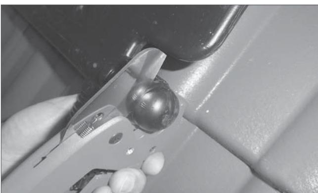
Die benötigten Anschlussstutzen mit einer Rohr-/Schlauchscherer aufschneiden.
