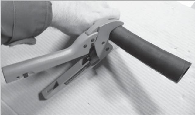
Der 40 mm Anbindeschlauch zum nächsten Absorber mindestens 12 cm mit der Rohr-/Schlauchschere aufschneiden.
