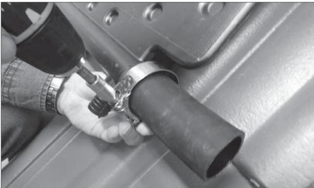
Den 40 mm Anbindeschlauch auf den Stutzen des ersten Absorbers bis zum Anschlag aufschieben.
