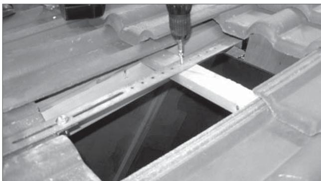
Universalbefestigungsanker mit beiliegenden Schnellbauschrauben auf Dachlatte fixieren. Universalbefestigungsanker muss im Wellental über den Ziegeln liegen.
