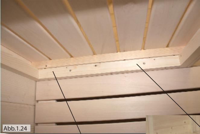
Auflageleiste unterhalb Querbank montieren - Schrauben 4 x 70 mm
